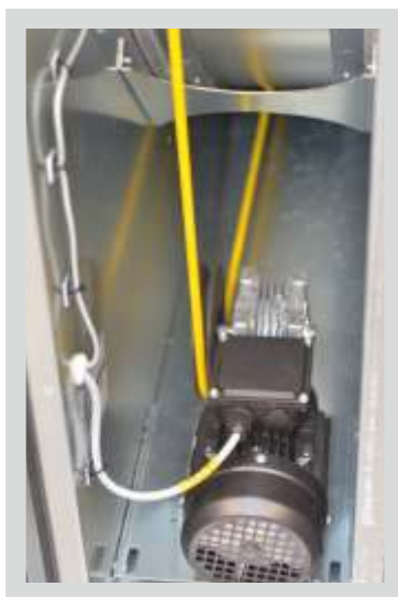
Wykonane połączenie silnika i sprężarek
